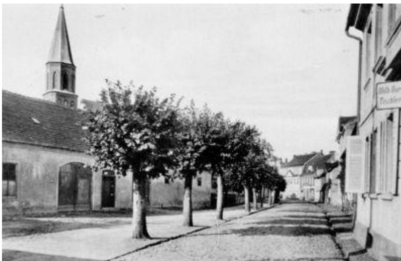
Ilustracja 6. Sulechów. Ulica Okrężna (dawna Reul) wjazd od strony ulicy Jana Pawła II. Za budynkami z lewej strony dawniej istniał mur obronny. Tylne ściany tych budynków posadowiono na murze obronnym, jako fundamentie.
